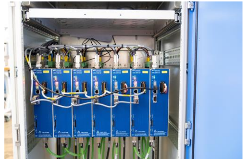
29931 Servoregler der Metronix-Reihe ARS 2000 SE arbeiten in den Mammut-Nähanlagen im Mehrachsverbund. Welcher Regler welche Aufgabe hat, ist auf einer SD-Karte klar festgelegt.
